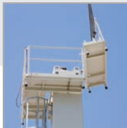
Montaggio di un braccio MX con la piattaforma di lavoro di sicurezza opzionale
