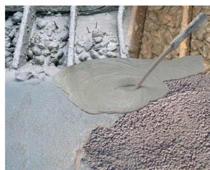
Transporta una amplia gama de materiales, incluidos los más difíciles de bombear como, por ejemplo, hormigón de fibras de acero, solados sueltos, hormigón aireado, hormigón autocompactante, hormigón líquido y hormigón ligero con distribuciones granulométricas de hasta 32 mm. Bombea incluso material quebrado si la mezcla de hormigón contiene una proporción adecuada de menudos.
