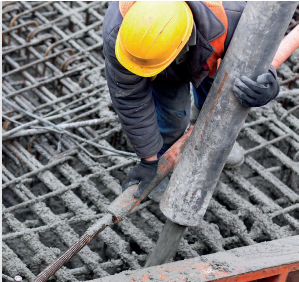
Zusätzlich bietet Putzmeister Betonförderschläuche auch mit einer Textilarkasse an. Diese Betonförderschläuche und Endschläuche sparen bis zu 15 % Gewicht ein, das sich sowohl bei der Handhabung durch den Maschinisten, als auch bei der Zuladung zur Maschine bemerkbar macht.
