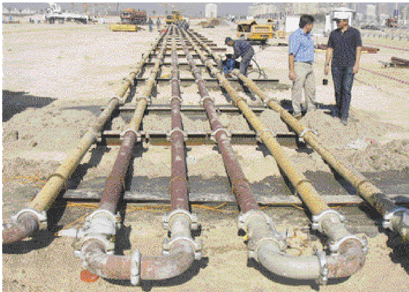
Um die Betonhochförderung unter Extrembedingungen zu simulieren, wurden zuvor Hunderte Meter Förderleitung horizontal verlegt, Messwerte und Faktoren wie Reibbeiwerte ermittelt und auf die Hochförderung umgerechnet
