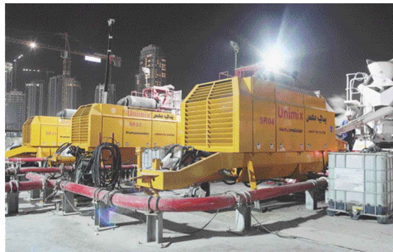
Wegen der hohen Temperaturen wird überwiegend nachts betoniert
