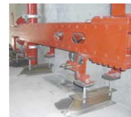
Für den Notfall: Mit dem „Eisernen Schwert“ ist jederzeit eine schnelle Entleerung der Steigleitung möglich
