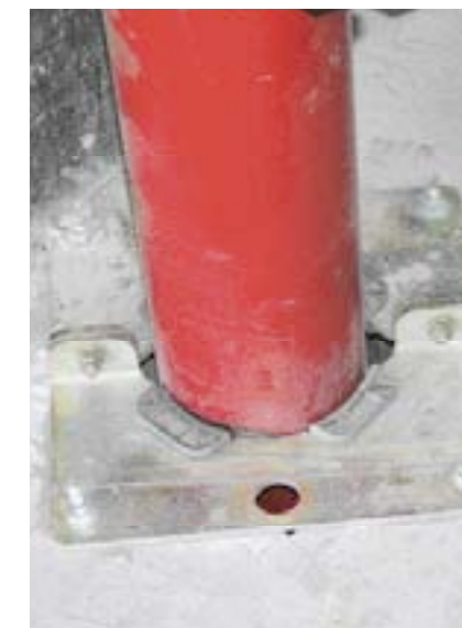
Die Pumpleitungen werden zwischen den Decken so geführt, dass sie nicht seitlich wegnicken können – vertikal sind sie jedoch frei beweglich
