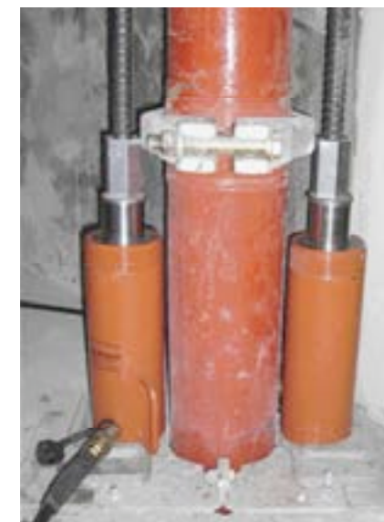
Falls einzelne Rohre ausgewechselt werden müssen, kann die gesamte Steigleitung von Hydraulikzylindern angehoben werden
